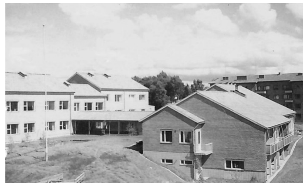
Rakennus on sovitettu taitavasti Köysimäen ääreen leikkipihojen antaessa etelään ja länteen. Kuva Tampereen kaupunginarkisto.
