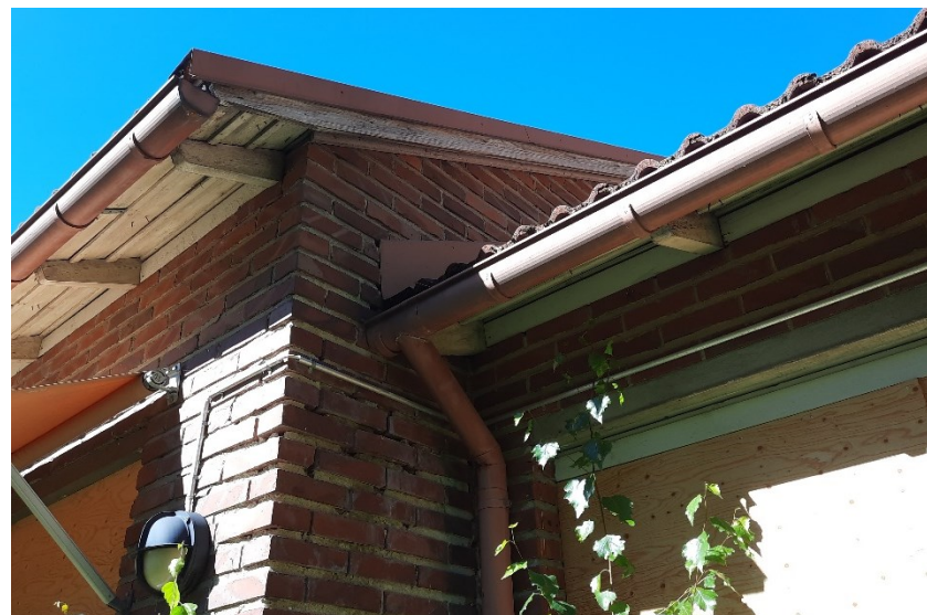
Kalevan lastentalon räystäsrakenteita. Kuva Tampereen kaupunki 2022.
